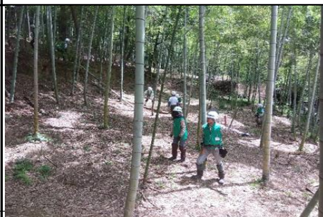
4日 一条寺廃竹材仮置場迄移動運び出し
