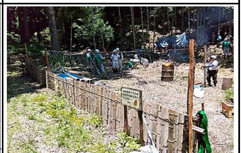
12日 萩谷公園 炭釜前広場防鹿ネット囲い設置
