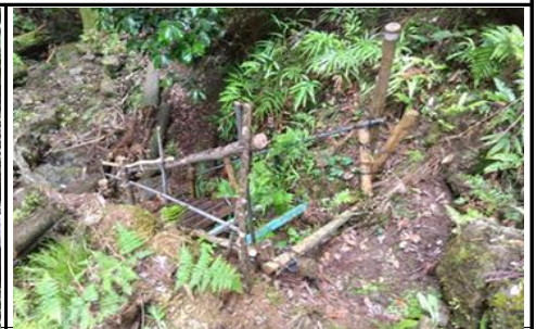
2日 楊梅山 散策路昇降階段補強
